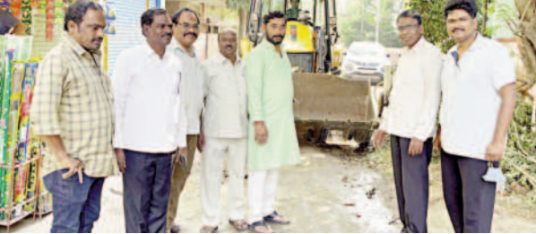
రోడ్డు పనులను ప్రారంభిస్తున్న ప్రేమ్‌మహేశ్వర్‌రెడ్డి
